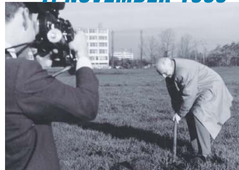
Eduard Haas beim Spatenstich, 1965.
